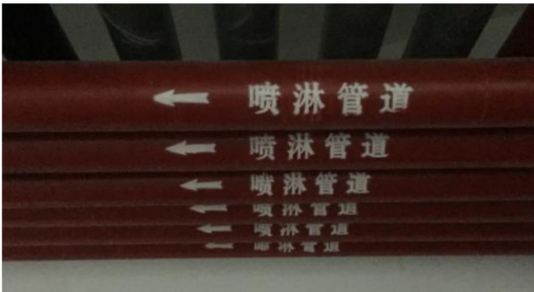
如图所示：当管道高于人员高度，文字尽量喷在管道下方，便于人员在地面观察管道介质、流向、压力。
