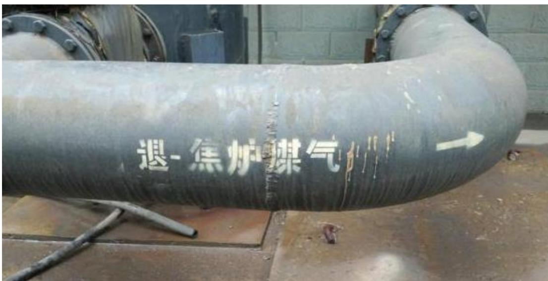
如图所示：当管道平行或低于人员高度，文字尽量喷在管道水平中间或上方，便于人员在地面观察管道介质、流向、压力。
